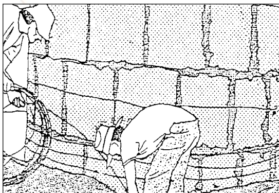
Figura 14: Amarração das paredes
