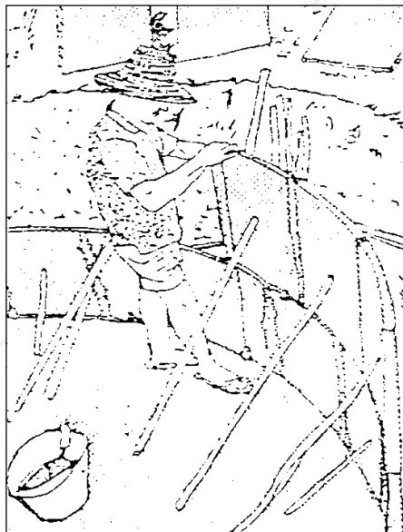
Figura 12: Montagem da segunda fiada
