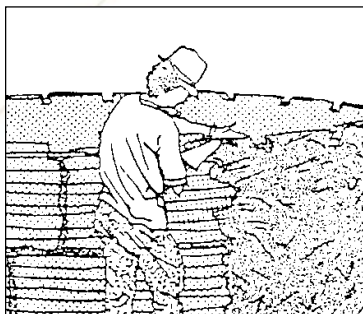
Figura 15: Reboco externo das paredes
