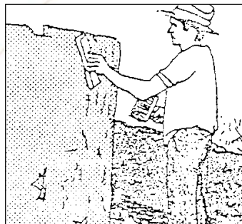
Figura 16: Acabamento do reboco externo
